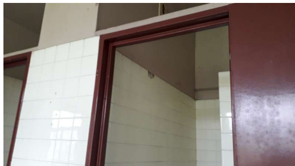
Prélèvement - P37 : R+0 / 00.021 - Colle de faïence- (Absence d'amiante)
