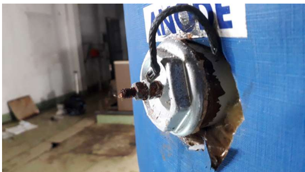
Prélèvement - P55 : R-1 / 0S1.03 - Joint- (Absence d'amiante)
