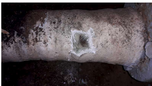
Prélèvement - P53 : R-1 / OS1.03 - Enveloppe de calorifugeage - (Absence d'amiante)
