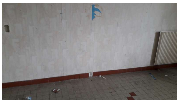
Prélèvement - P29 : R+0 / 00.020 - Colle de plinthe- (Présence d'amiante)
