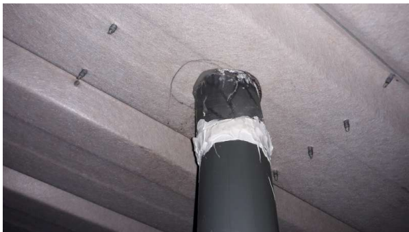
Prélèvement - P4 : R+2 / 02.001 - Mastic- (Absence d'amiante)
