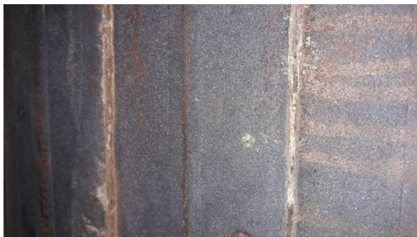
Prélèvement - P60 : R-1 / OS1.03 - Joint- (Absence d'amiante)
