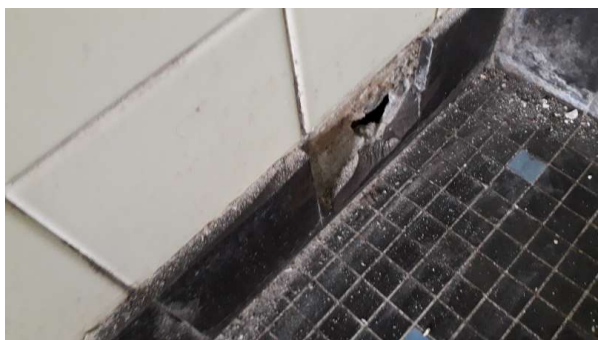
Prélèvement - P36 : R+0 / 00.021 - Colle de plinthe- (Absence d'amiante)
