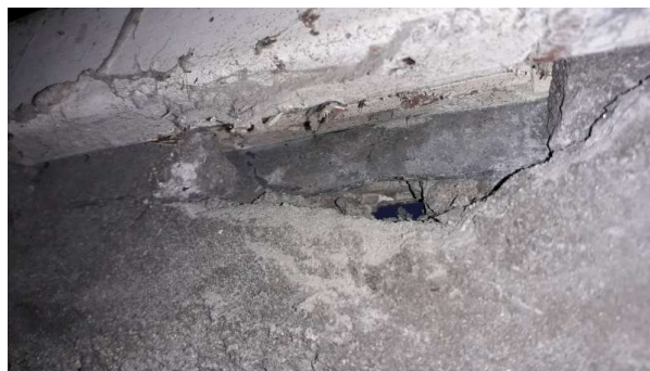
Déclaré - : R+2 / 02.001 - Joint- (Absence d'amiante)
