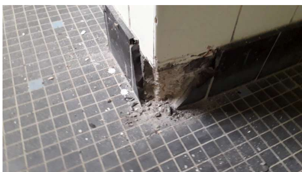
Prélèvement - P18 : R+1 / 01.010 - Colle de plinthe- (Absence d'amiante)
