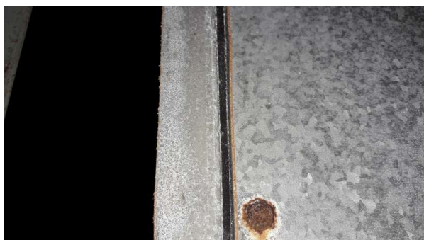
Déclaré - : R+2 / 02.004 - Joint- (Absence d'amiante)
