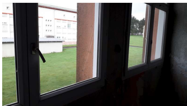
Prélèvement - P16 : R+1 / 01.009 - Joint d'étanchéité entre menuiserie et structure- (Absence d'amiante)
