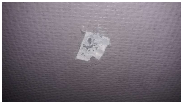
Prélèvement - P72 : R+0 / 00.004 - Peinture- (Absence d'amiante)
