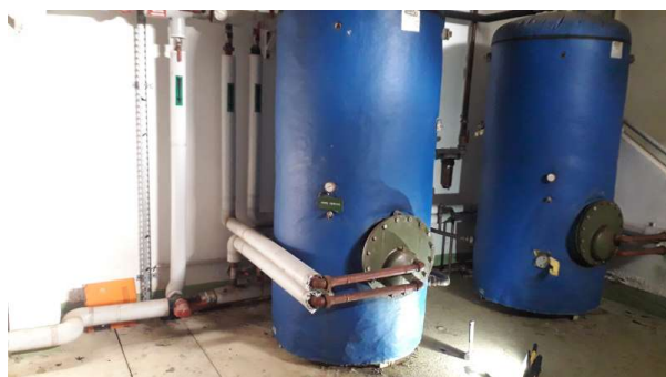
Prélèvement - P54 : R-1 / OS1.03 - Joint- (Présence d'amiante)
