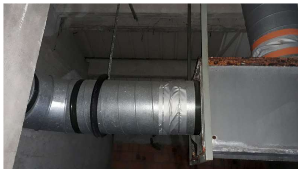
Prélèvement - P7 : R+2 / 02.004 - Soufflet- (Absence d'amiante)
