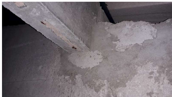
Prélèvement - P2 : R+2 / 02.001 - Rebouchage- (Absence d'amiante)
