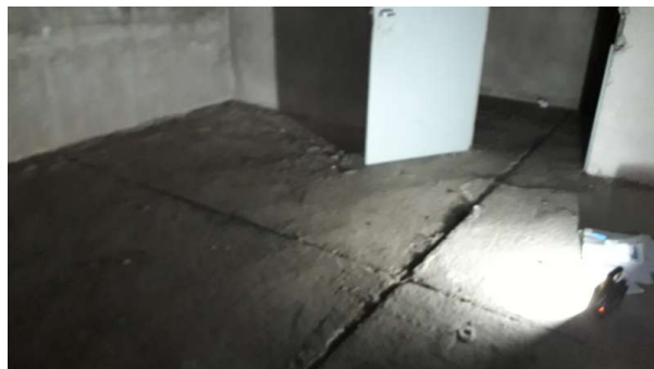
Prélèvement - P44 : R-1 / 0S1.16 - Joint de dilatation- (Absence d'amiante)
