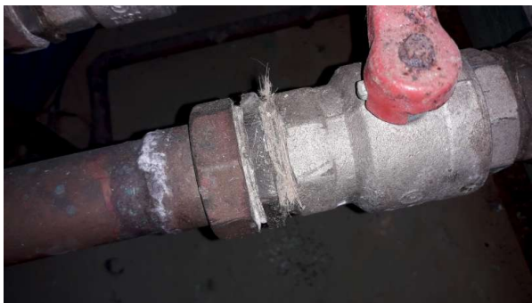
Prélèvement - P56 : R-1 / 0S1.03 - Joint- (Absence d'amiante)
