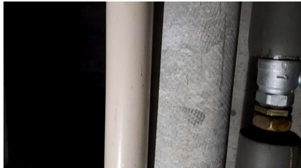
Prélèvement - P1 : R+2 / 02.001 - Conduit- (Présence d'amiante)
