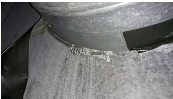
Prélèvement - P6 : R+2 / 02.004 - Mastic- (Absence d'amiante)
