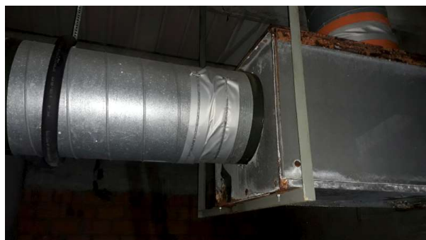
Prélèvement - P6 : R+2 / 02.004 - Mastic- (Absence d'amiante)
