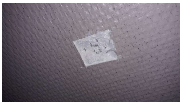
Prélèvement - P73 : R+0 / 00.006 - Peinture- (Absence d'amiante)
